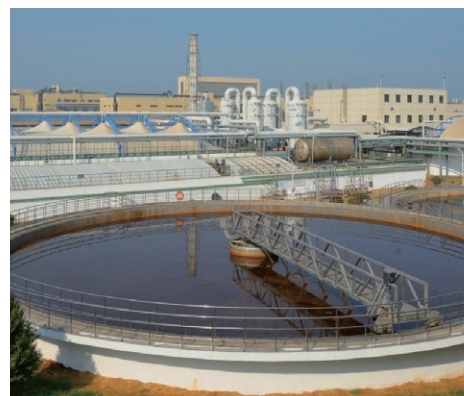
天方药业污水处理池
